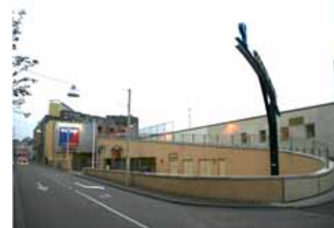
bestaande situatie oprit parkeerdek Molenpoort
