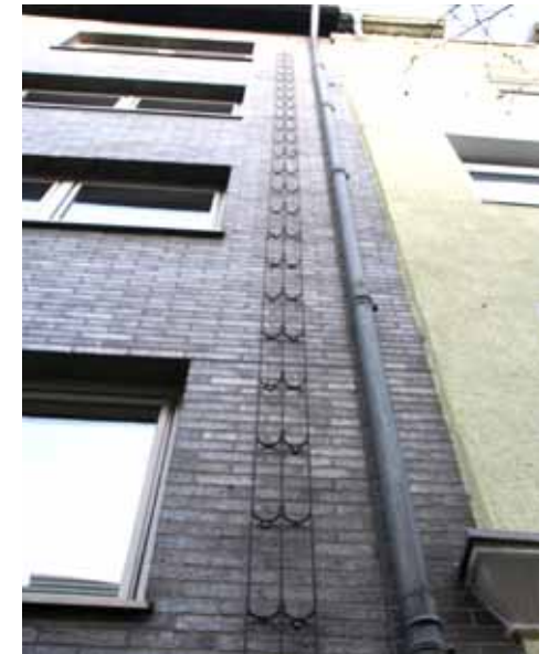
referentie: detaillering klimconstructie in Keulen
